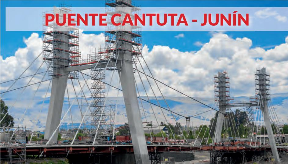
En la ciudad de Huancayo, región Junín, se llevó a cabo un proyecto que combinó precisión, seguridad y creatividad técnica. Layher fue designada para diseñar y asesorar la instalación de un sistema de andamio en los pilares del Puente Cantuta, con el objetivo de facilitar la colocación de nuevos cables tensores.
